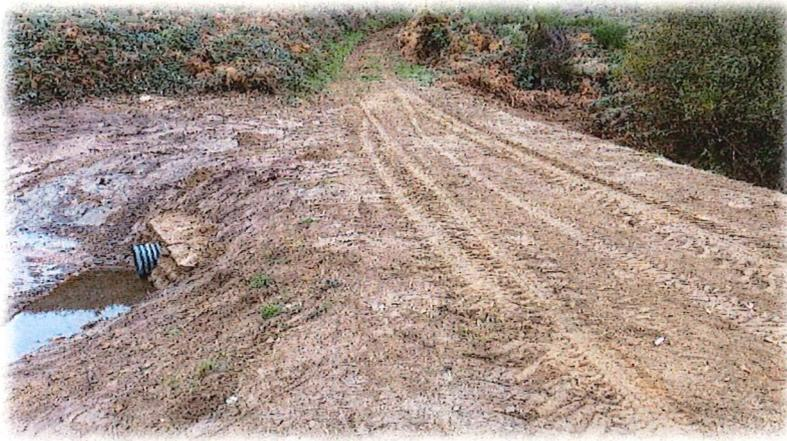
**A Rouzeyrol** : Réfection d'un chemin avec pose d'un nouveau passage busé.
